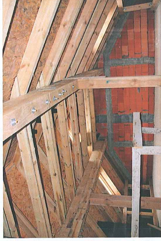
Drewniana konstrukcja dachu budynku mieszkalnego
